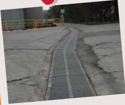
ÇBİ su kanallarının düzenlenmesi tamamlandı.
