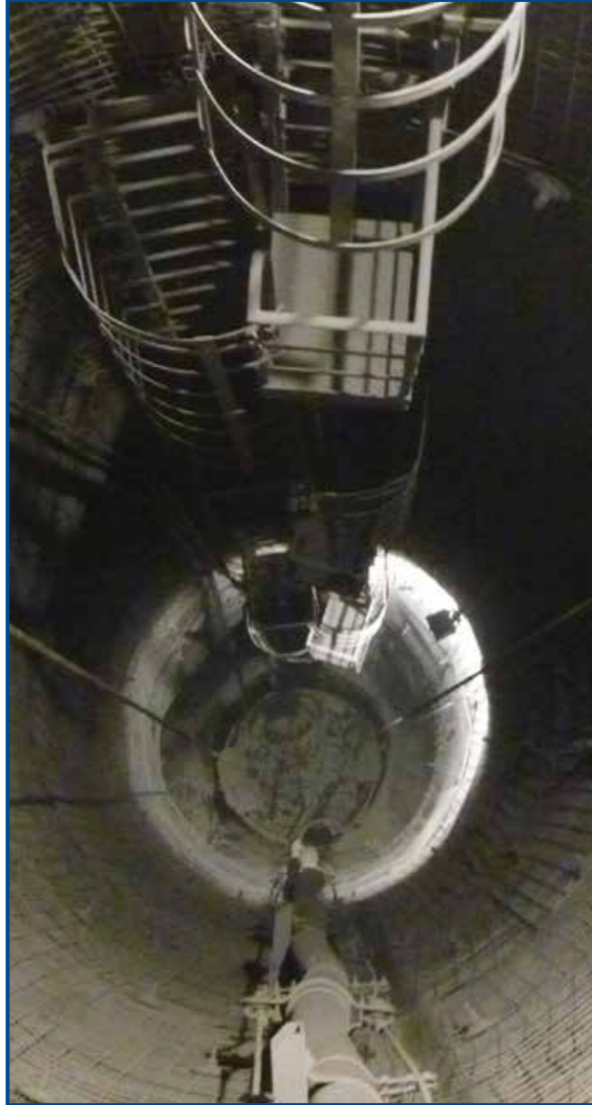
Dik Orepass inşaatı
